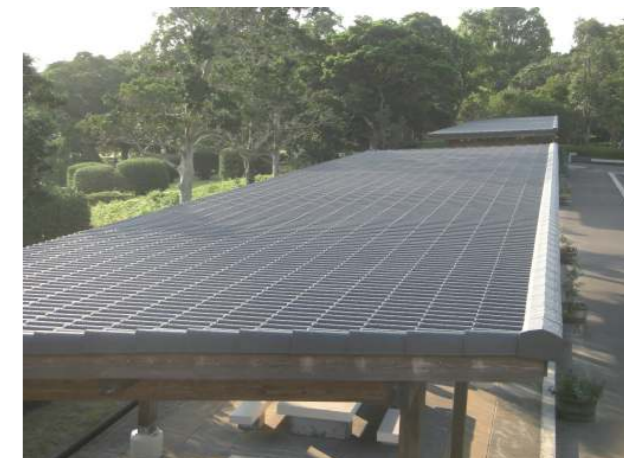
写真4 ユーロベスト S-30 施工例(一寸勾配)
