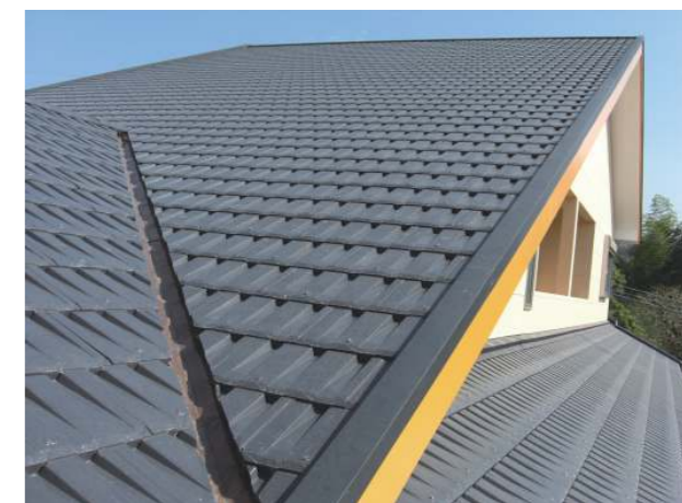
写真5 石娘 S-24 施工例
