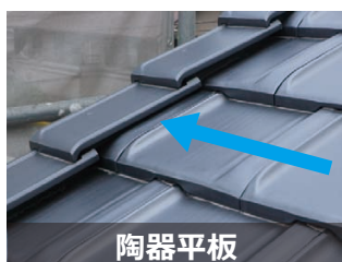
袖部から水が侵入したケースも。
