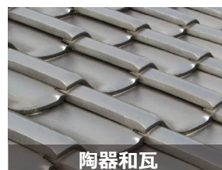
焼き物特有の歪みによる隙間。
