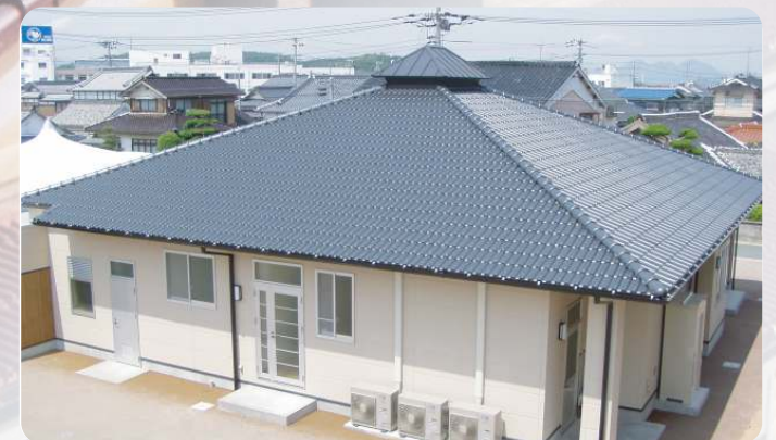
中村公民館〈山口県〉 設計 (有)匠建築設計事務所 瓦色 モノトーン EC-410アンバーブラック 4寸勾配 スルーホール工法
