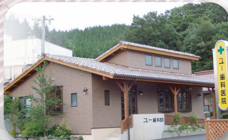
ユー歯科〈山口県〉 設計 (有)アリタ建築設計事務所 瓦色 マルチトーン PC-06 ラベンダレッド 3寸勾配 スルーホール工法
