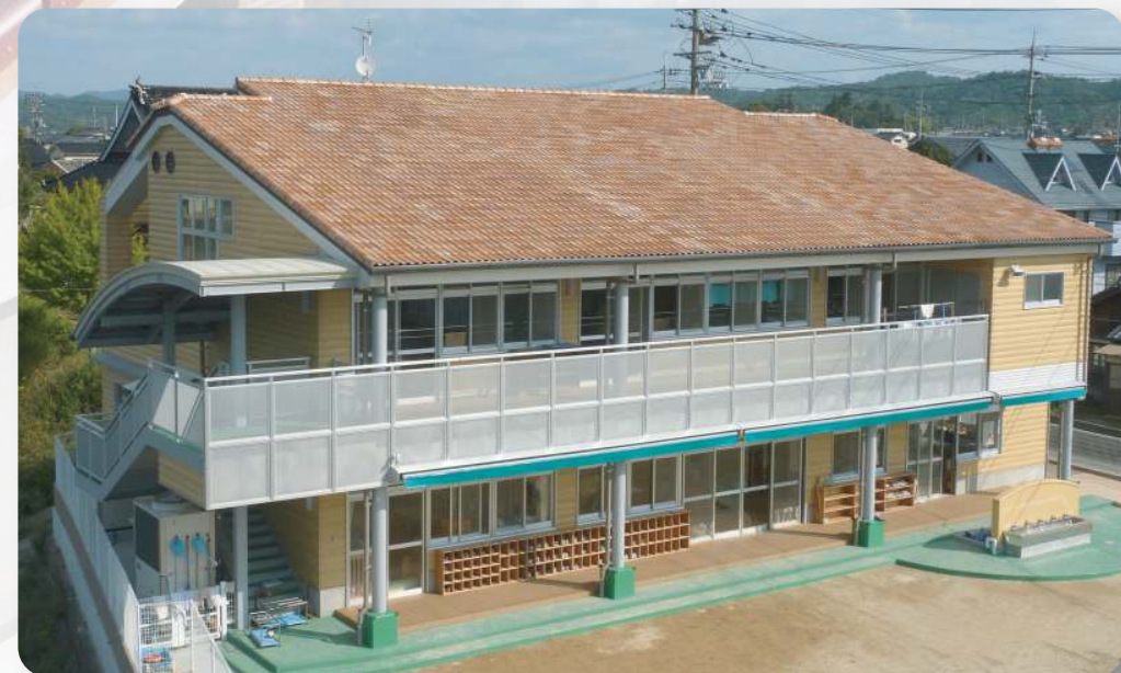
貞源寺保育園〈山口県〉 設計 (有)アリタ建築設計事務所 瓦色 マルチトーン PC-02マーブルオレンジ 3寸勾配 スルーホール工法
