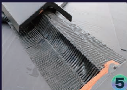
完全乾式施工 (棟部)
