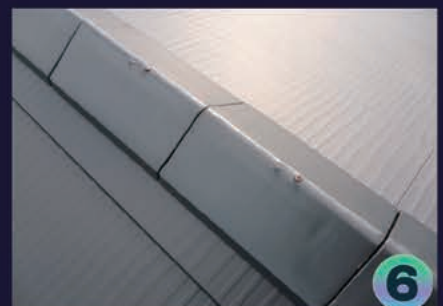
陶器冠瓦・棟部施工
