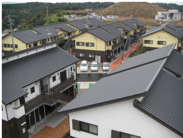
図-3 シラス和瓦 新築屋根工事 (鹿児島市, 県営住宅松陽台団地)
