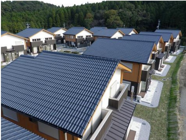
図-5 シラス洋瓦 新築屋根工事 (鹿児島市、県営住宅松陽台第二団地)
