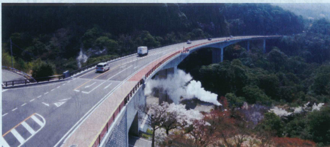
▲基礎にシラスコンクリートを使用し建設した「丸尾の滝橋」
