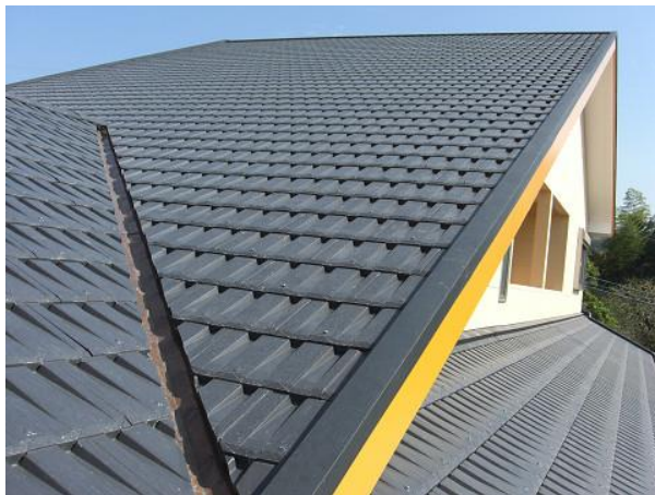
図-6 シラス大判瓦 新築屋根工事 (さつま町、個人住宅)
