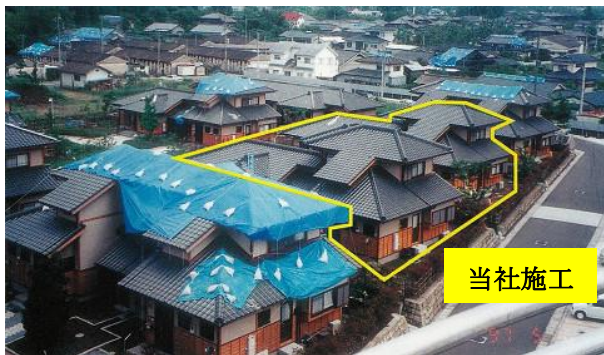
図-2 被害が最小限に抑えられた住宅 (さつま町, 県営住宅観月台団地, HITTO-BAN)
