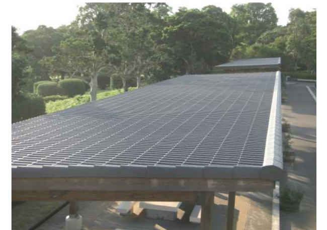
写真4 ユーロベスト S-30 施工例(一寸勾配)
