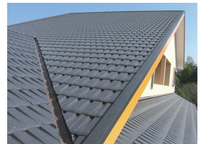
写真5 石娘 S-24 施工例
