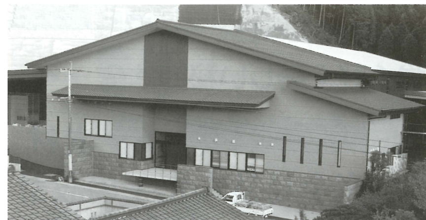
最近竣工した「西酒造米加工場」(日置市)。約600㎡(勾配2.5寸)の屋根にシラス洋瓦「ユーロベスト S-30」が採用された
