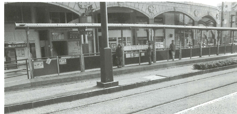
市電の軌道に芝付き緑化基盤を敷設した鹿児島市の事例。ヒートアイランド対策の一環でもある
